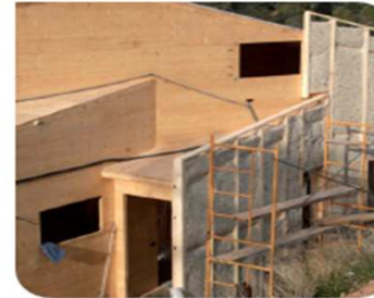
Fachadas de madera
